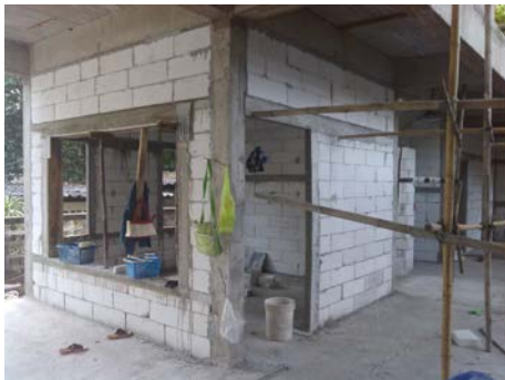
งานก่ออิฐชั้น 1
