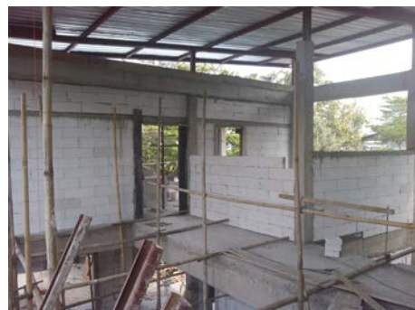
งานก่ออิฐชั้น 2
