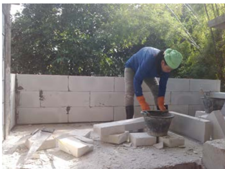
งานก่ออิฐชั้น 2
