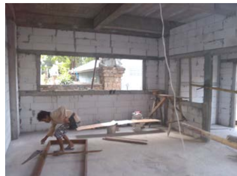
งานก่ออิฐชั้น 1
