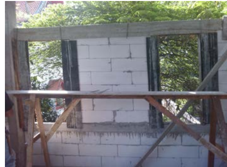
งานเสาเอ็น+ทับหลัง
