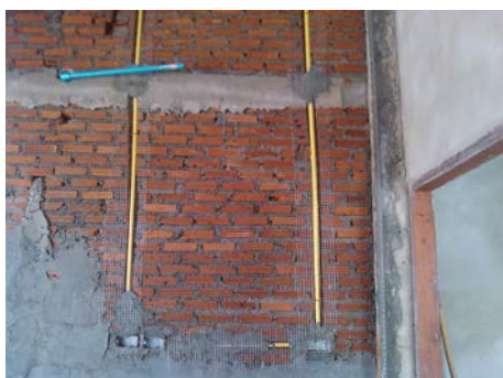
งานติดตั้งลวดตาข่ายก่อนฉาบปูน
