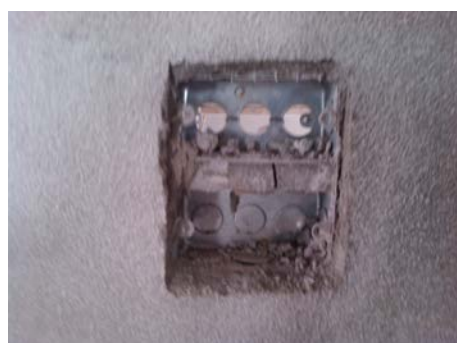
งานติดตั้งเต้ารับไฟฟ้า
