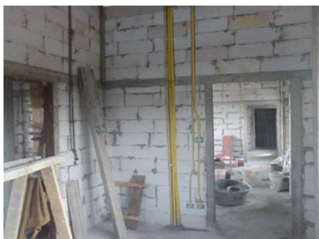
งานฝังท่อร้อยสายไฟ ชั้น 2
