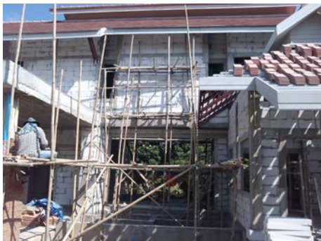
งานก่ออิฐผนังชั้น 2
