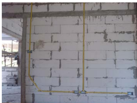
งานฝังท่อร้อยสายไฟฟ้าชั้น 1
