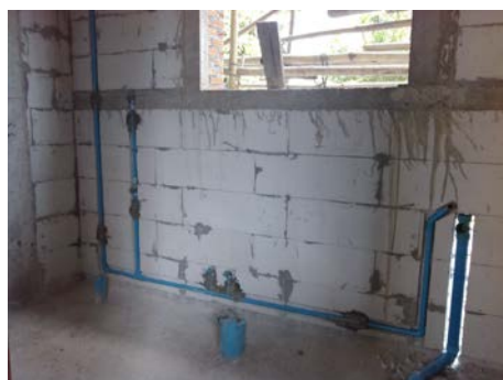
งานเดินท่อระบบประปา
