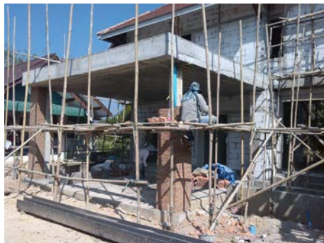
งานก่ออิฐกรอบเสา
