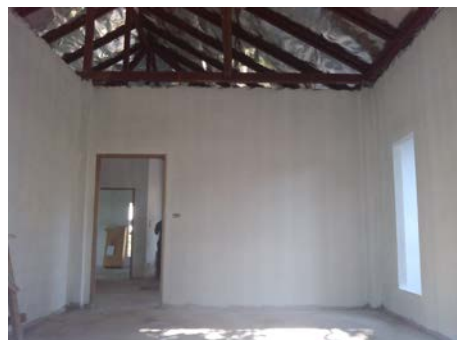
งานทาสีรองพื้นภายใน
