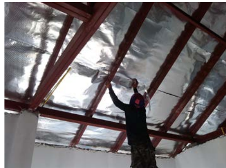
งานติดเทปฟรอยด์แผ่นสะท้อนความร้อน
