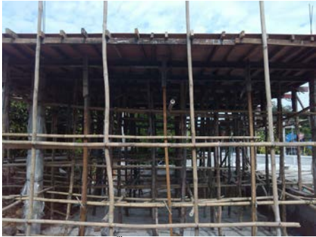
งานชั้นลาดฟ้าโรงรถ
