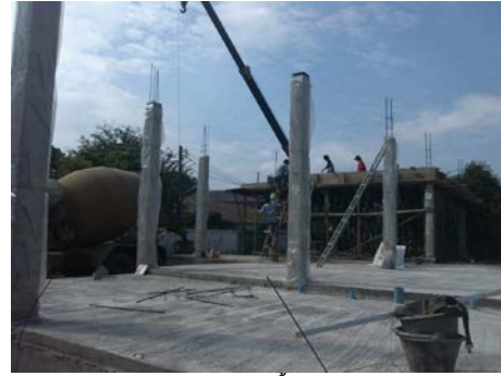
งานเทคอนกรีตพื้นลาดฟ้าโรงรถ
