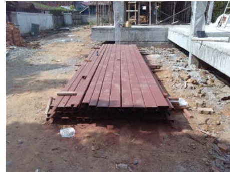
งานชุบสีกันสนิม โครงหลังคา
