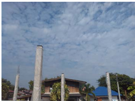
งานติดตั้ง Steel plate หัวเสา
