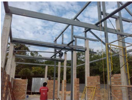
งานปรับแก้โครงหลังคา
